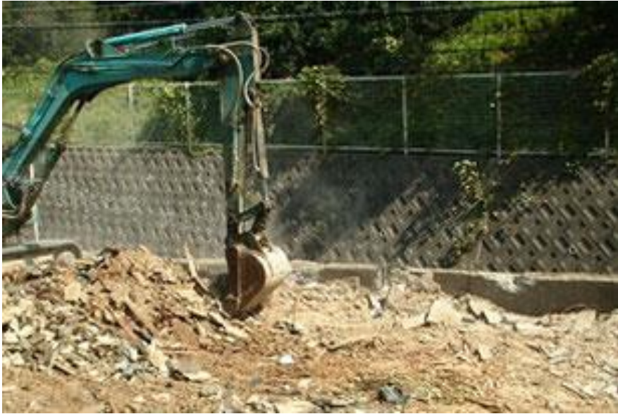
基礎・ガラ撤去
