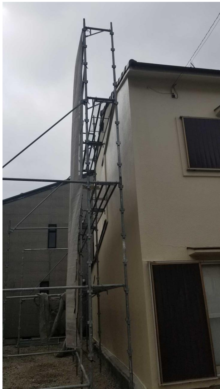
⑧塗装工事
