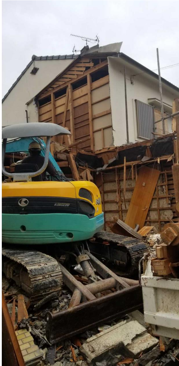
③重機解体中
